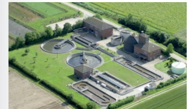
Die Kläranlage in Biblis
